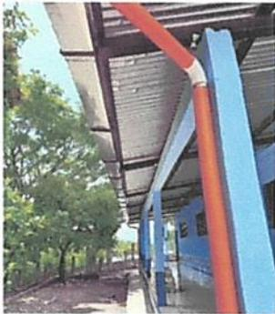
Foto 1: Canales instalados
